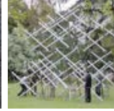
David Georges Emmerich, Varsovie, 1981, empilement autotendant à barres orthogonales dans un réseau icosaoé- drique tendu, tubes en aluminium, câbles en inox, 450x450x450 cm, Saint-Cyr-Sur-Loire, parc de La Perraudière, 2012.
